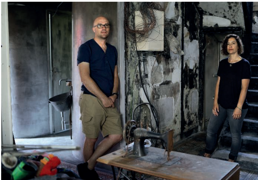
▲ Un incendie a ravagé, le 14 mai, la maison de Sylvain et Maya Montier, à Montreuil. Le départ de feu est venu, selon eux, du compteur, posé trois semaines plus tôt.
